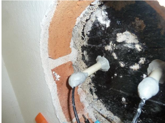
Maanvastaisten seinien bitumi ei sisällä asbestia, eikä vaarallisia määriä PAH-yhdisteitä.
