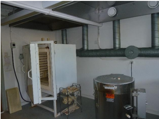
Peltikanavan kitti ei sisällä asbestia.
