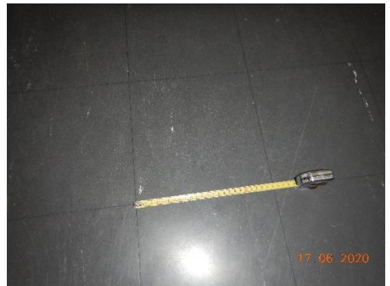
Kuva 9. Myös musta vinyylilaatta ja sen kiinnitykseen käytetty musta liima, näyte 23, sisälsi asbestia, kaikki 250 x 250 kokoiset vinyylilaatat käsitellään asbestipitoisena.
